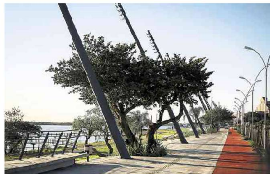
Trabalhos no local começaram em outubro de 2015 e estão 98% concluídos
