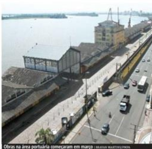
Obras na área portuária começaram em março | BRUNO MARTINS/OPERA
